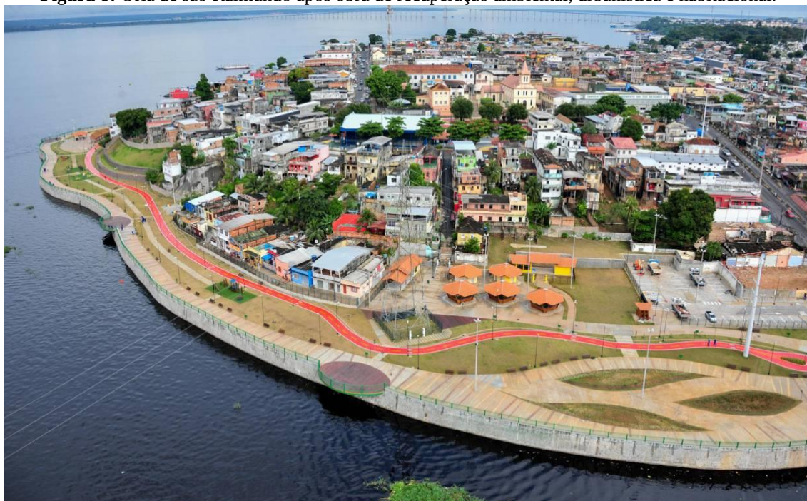
Figura 8: Orla de São Raimundo após obra de recuperação ambiental, urbanística e habitacional.
