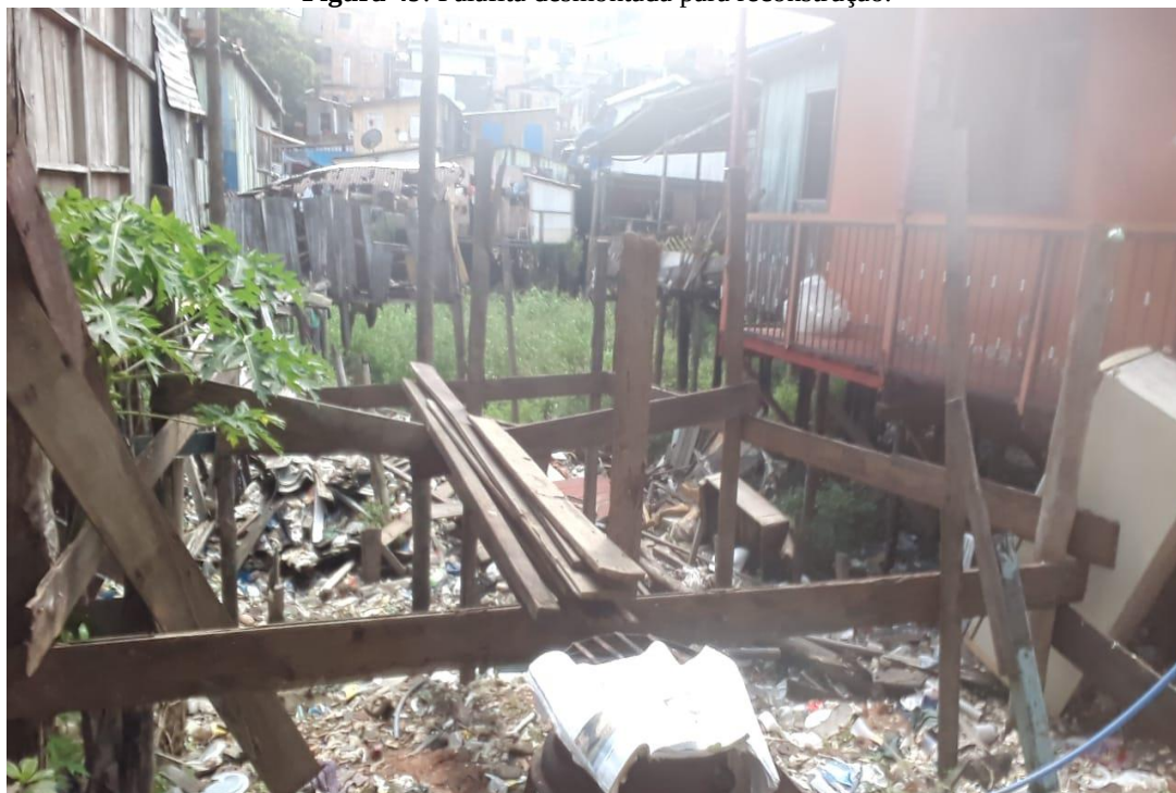
Figura 49: Palafita desmontada para reconstrução.
