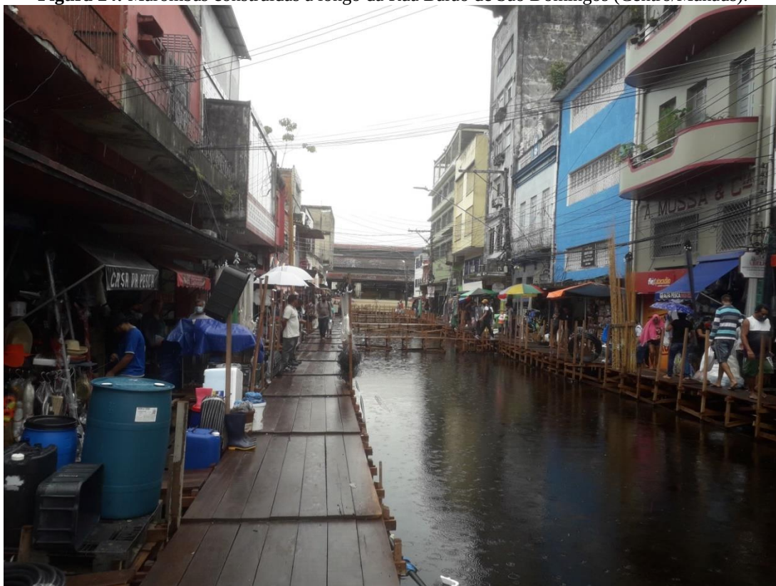
Figura 24: Marombas construídas a longo da Rua Barão de São Domingos (Centro/Manaus).
