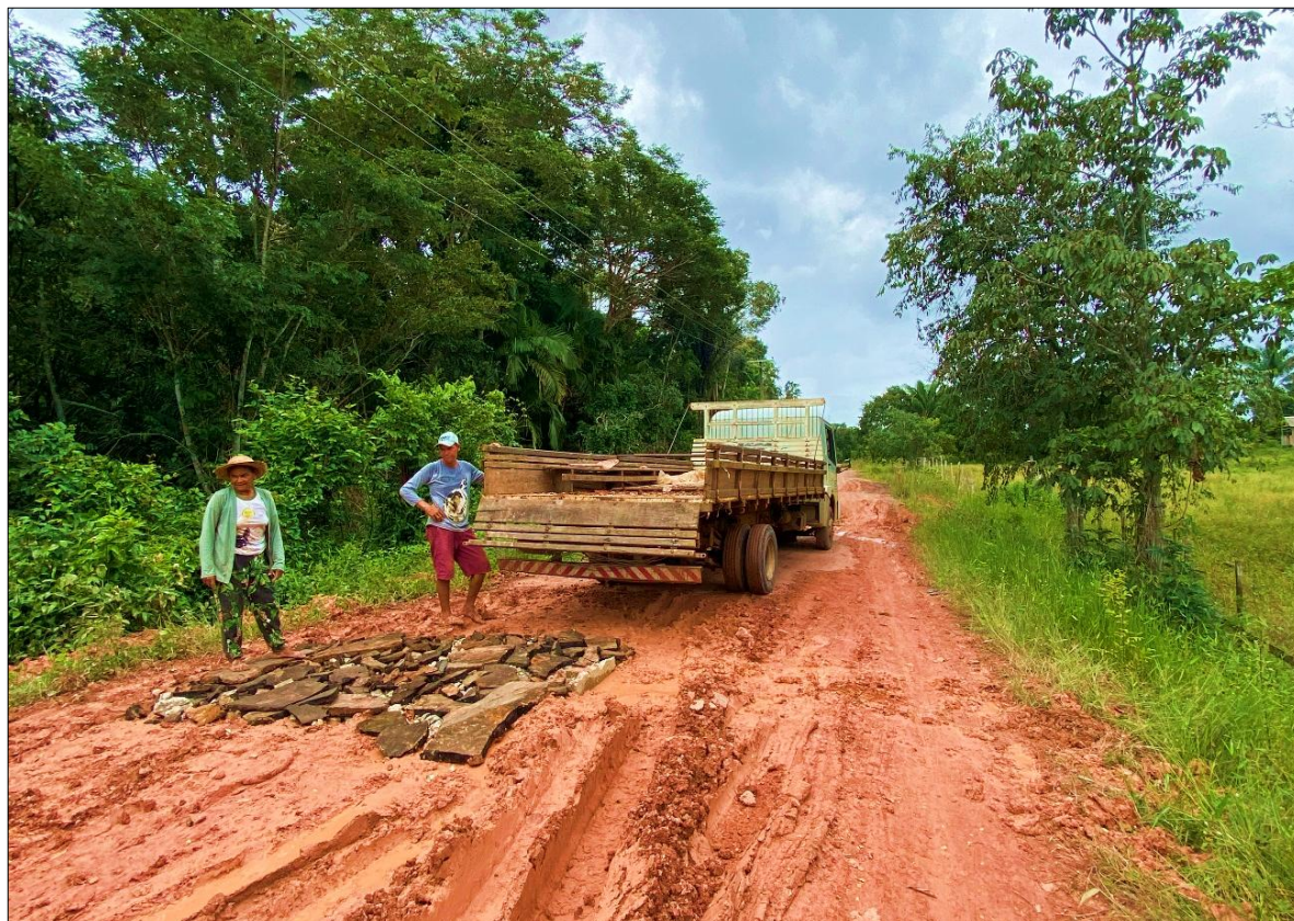
Figura 14 – Dona Socorro e seu filho Robson transferem rejeitos de massa asfáltica para trajetos da vicinal que foram deteriorados pela ação dos eventos chuvosos.
