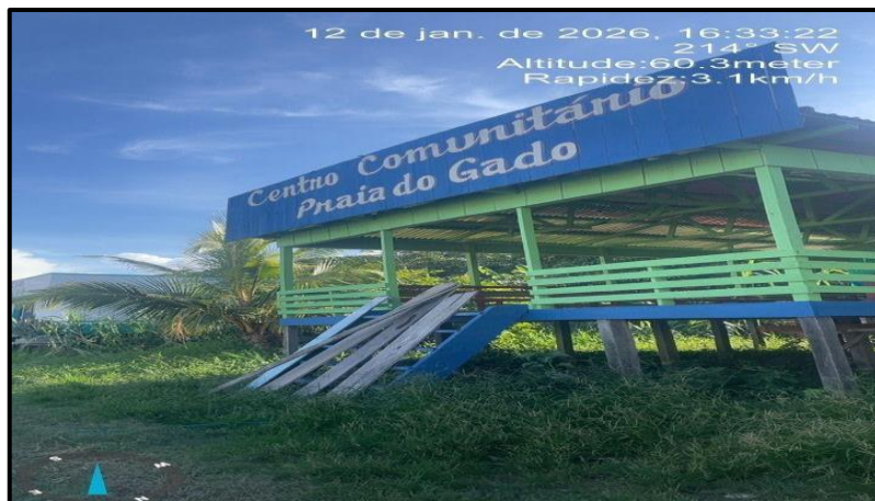
Figura 6 - Centro Comunitário na Comunidade ribeirinha Praia do Gado em construção
