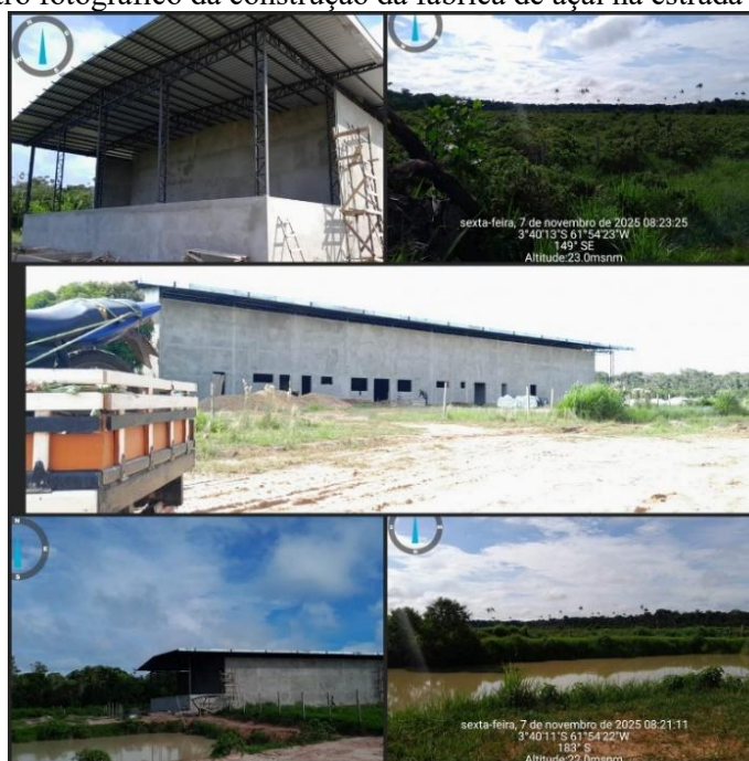
Figura 34 - Registro fotográfico da construção da fábrica de açaí na estrada Codajás-Anori/AM
