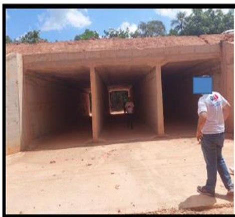
Figura 14 - Passagem de Fauna localizada no Km 205 da BR-319 (Lote C)
