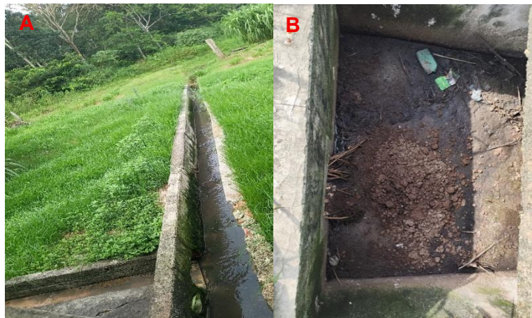
Figura 8 - Sistema de escoamento de dejetos (A). Esterqueira (B).
